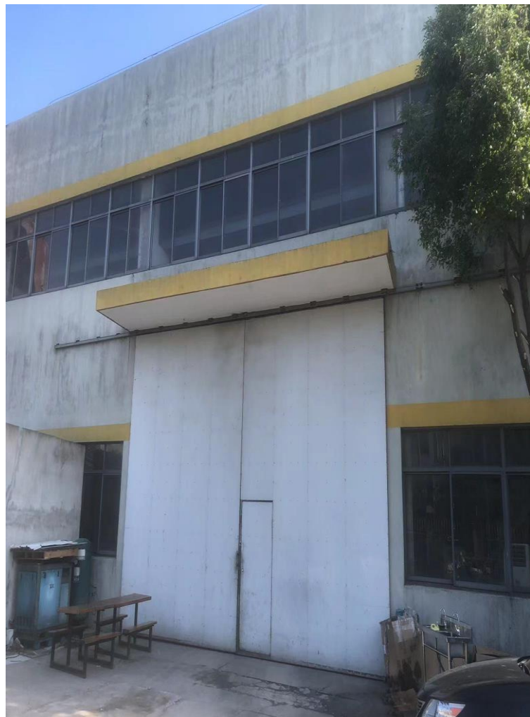
附图 6-2 本项目厂房外部现状照片
