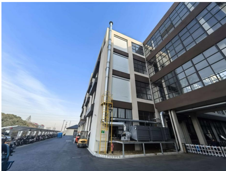
干式过滤器+二级活性炭吸附装置+DA001 排气筒
