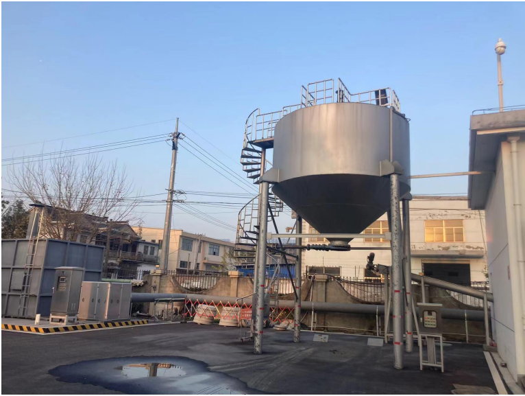
污泥（污泥罐满后即时安排处理）
