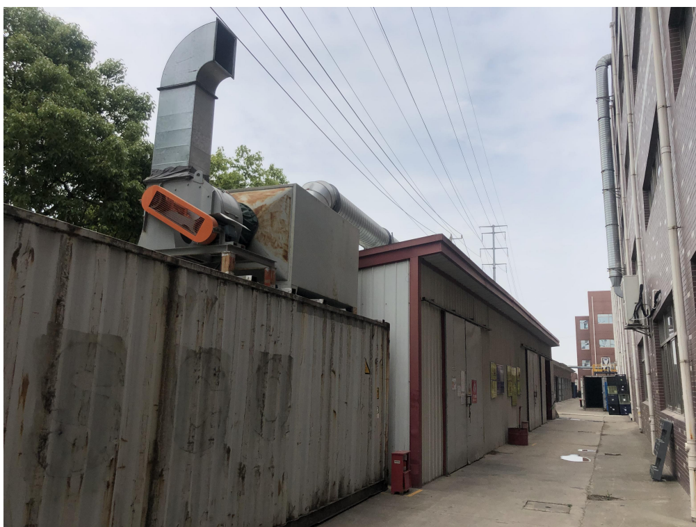
图4.3-2 危险废物暂存仓库外部
