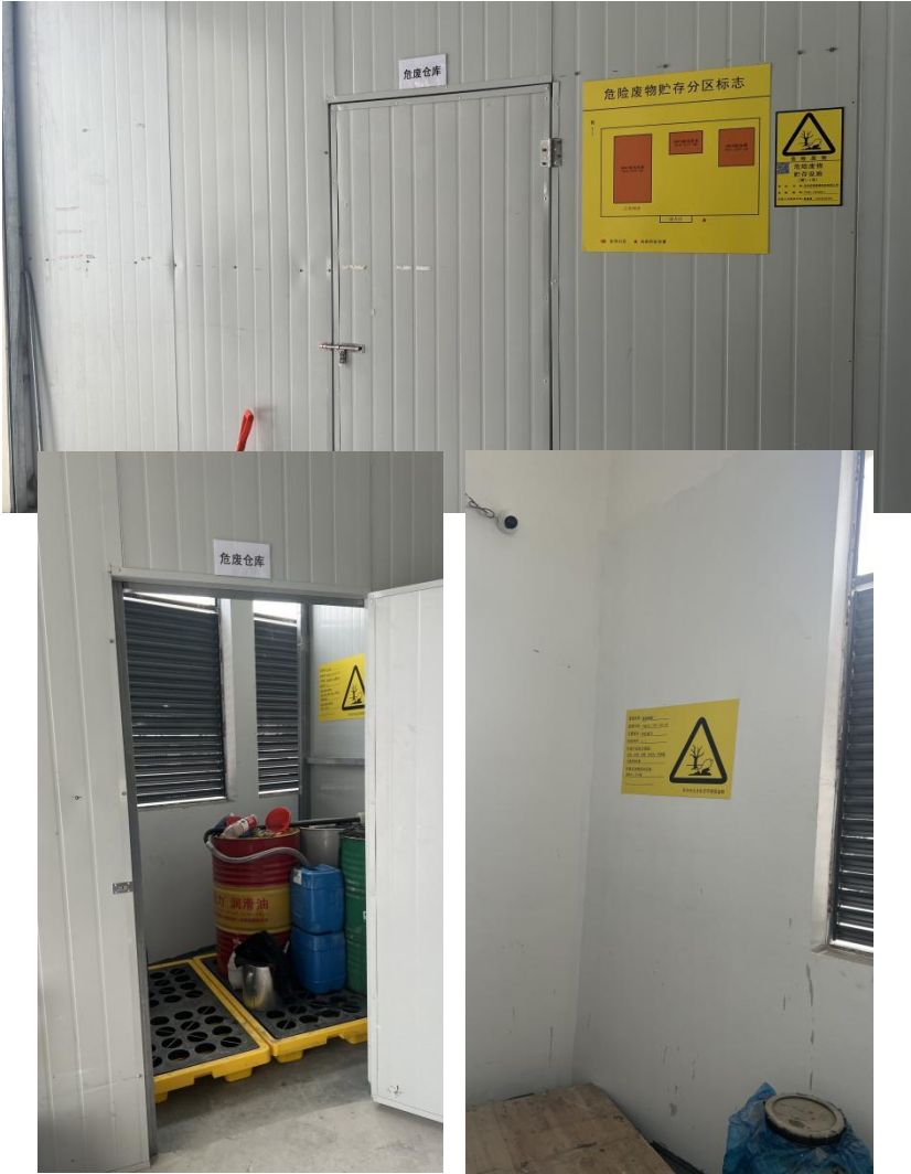
危险废物仓库
