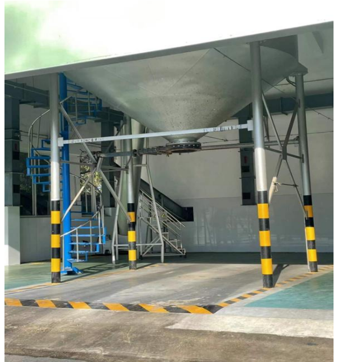
污泥（污泥罐满后即时安排处理）
