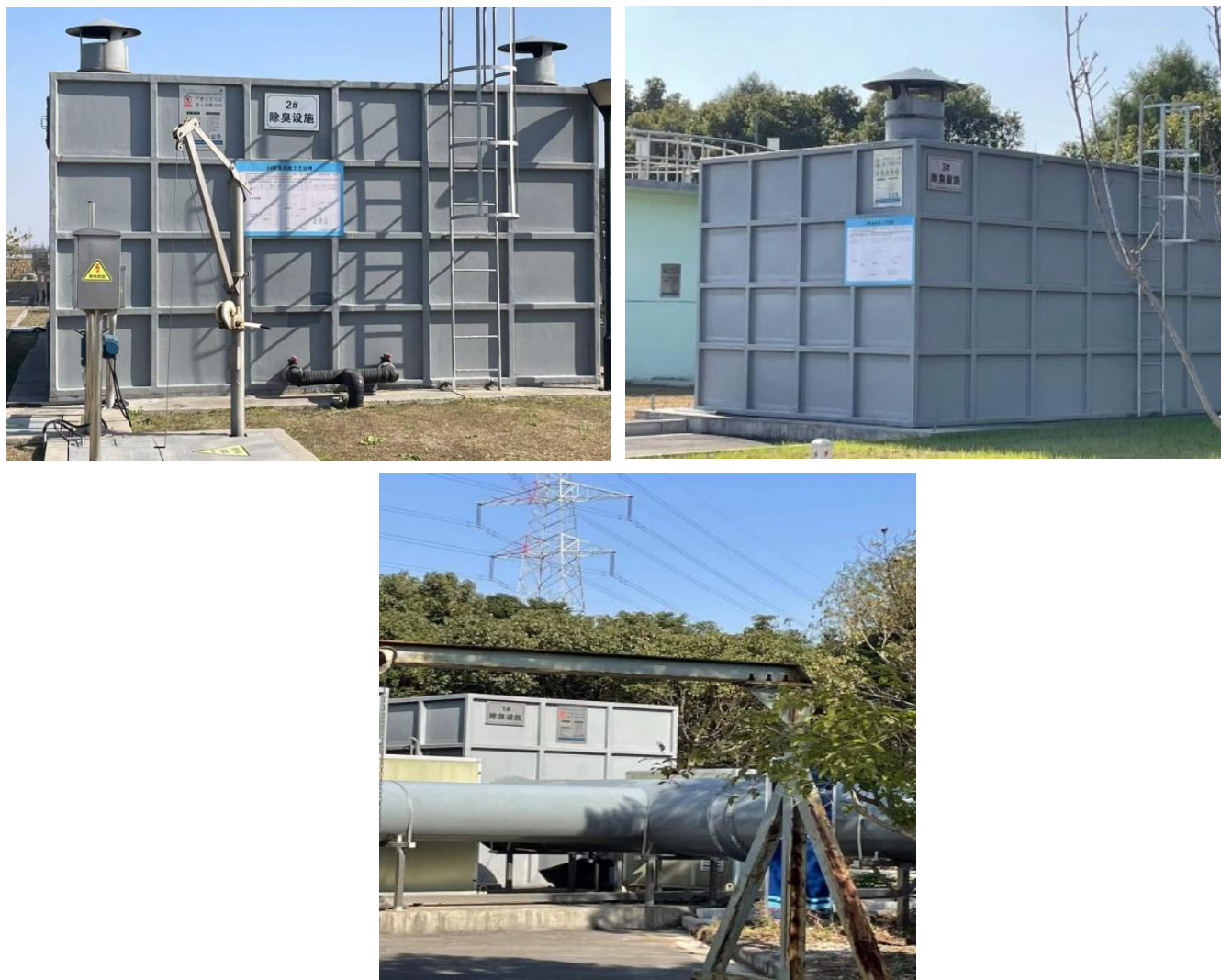
图 4-4 生物除臭装置（共三套）
