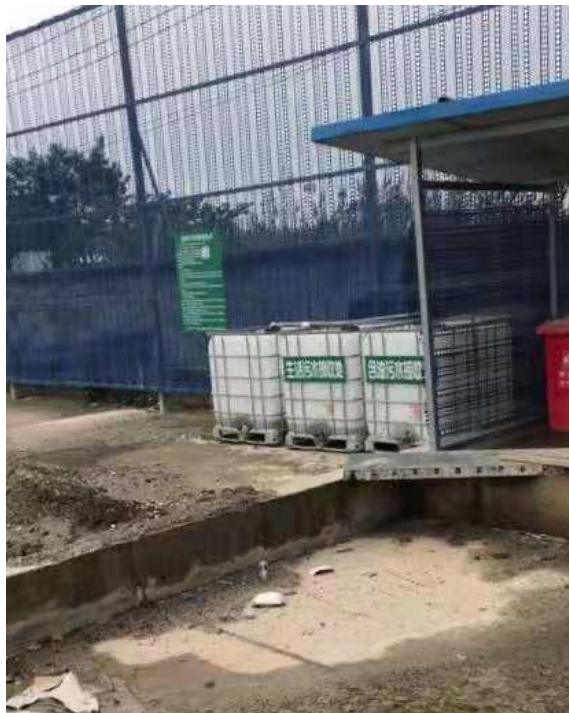
生活污水、含油污水接收处
