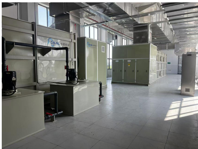
卸料大厅、垃圾卸料区、转运大厅的两套植物液喷淋装置
