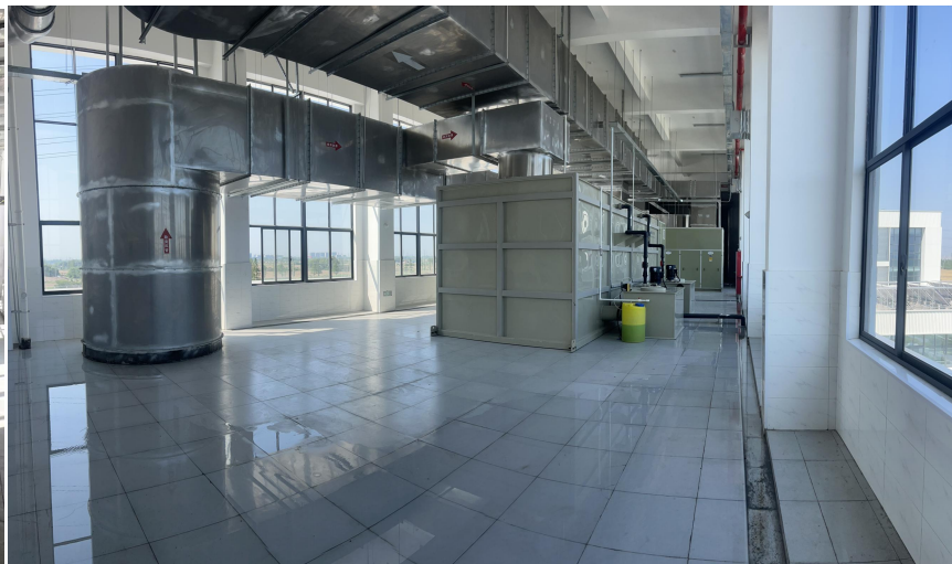
卸料大厅、垃圾卸料区、转运大厅的两套植物液喷淋装置
