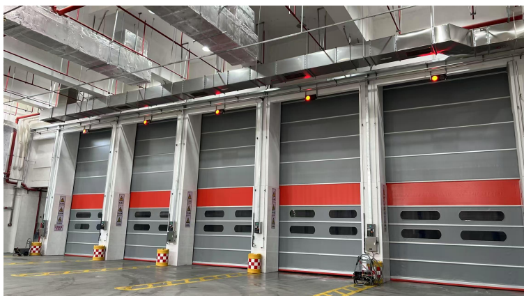
卸料大厅、垃圾卸料区、转运大厅废气负压收集
