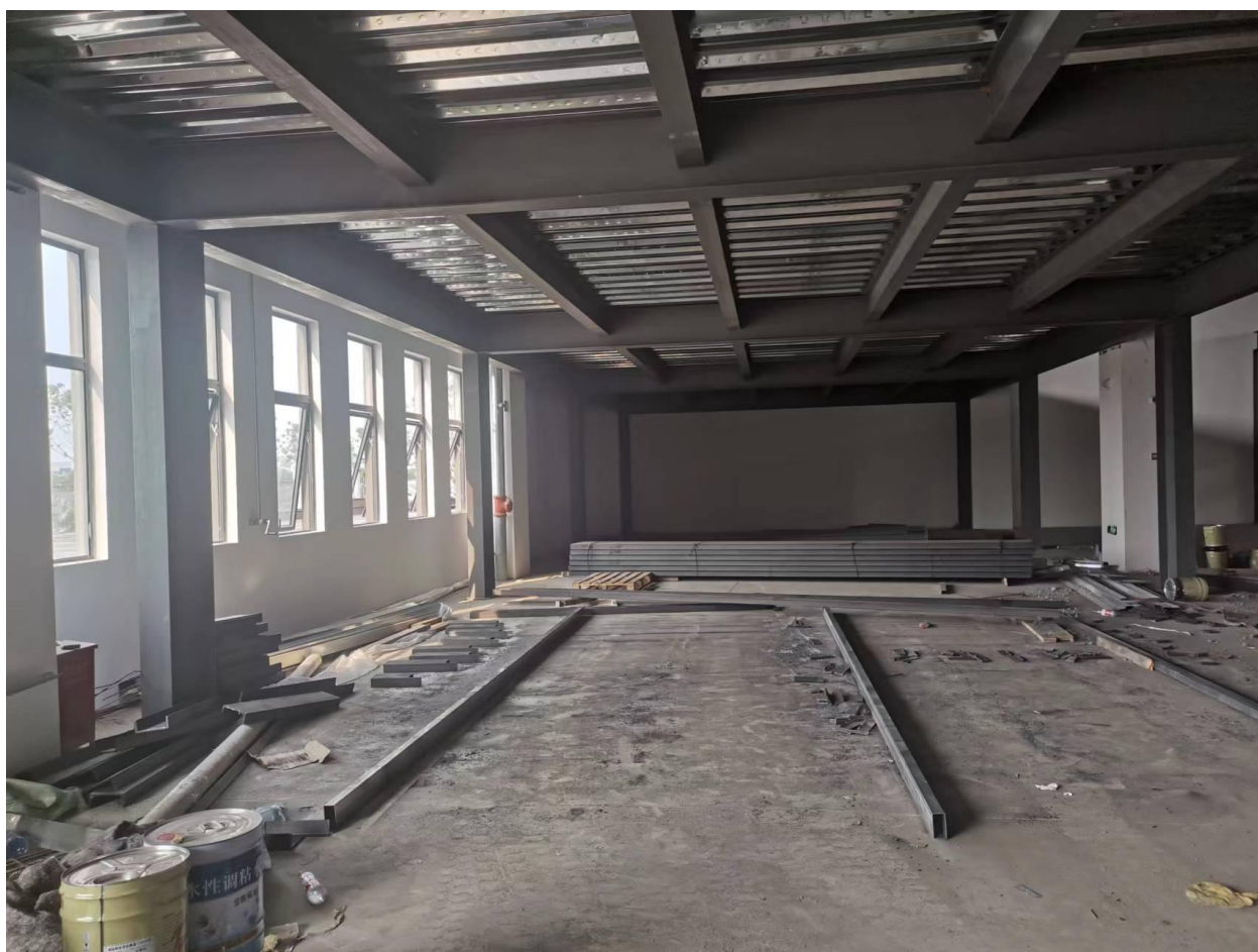
附图 5-1 本项目车间现状照片
