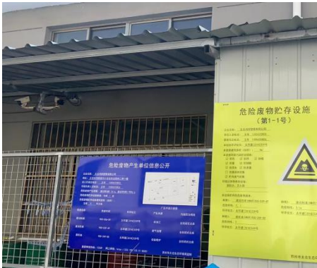
危废仓库外部摄像头
